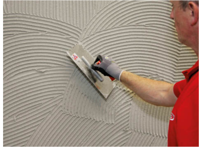
Aufziehen der Kontaktschicht und des Kammbetts in der Dünnbettkonsistenz.
