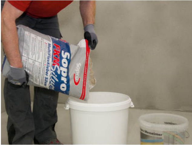
Anrühren von Sopro FKM® Silver in der gewünschten Konsistenz für die Verlegung im Dünn-, Fließ- oder Mittelbett bzw. zum Spachteln.
