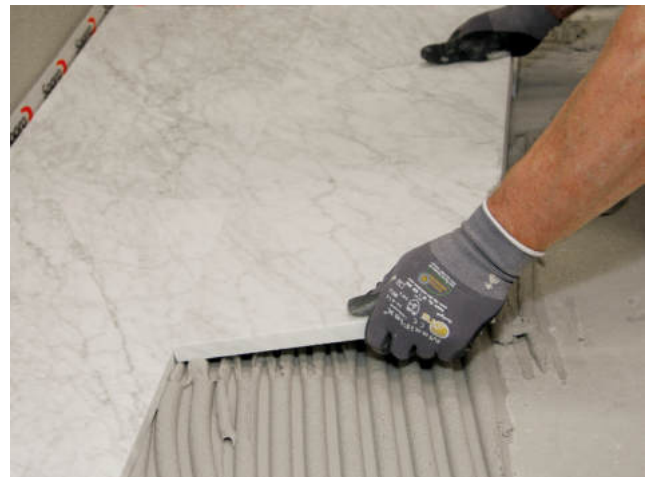
Einlegen einer Natursteinplatte. Aufgrund der hellen Farbe eignet sich Sopro FKM® Silver auch für die Verlegung durchscheinender Materialien.
